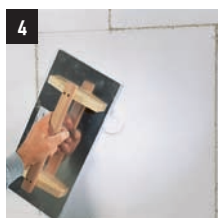
Εικόνα 4 Τρίβουμε τα StoThermo EPS Roundels. Τα βύσματα δεν πρέπει να αφήνουν καμία ατέλεια πάνω στην τελική επιφάνεια των πλακών διογκωμένης πολυστερίνης
